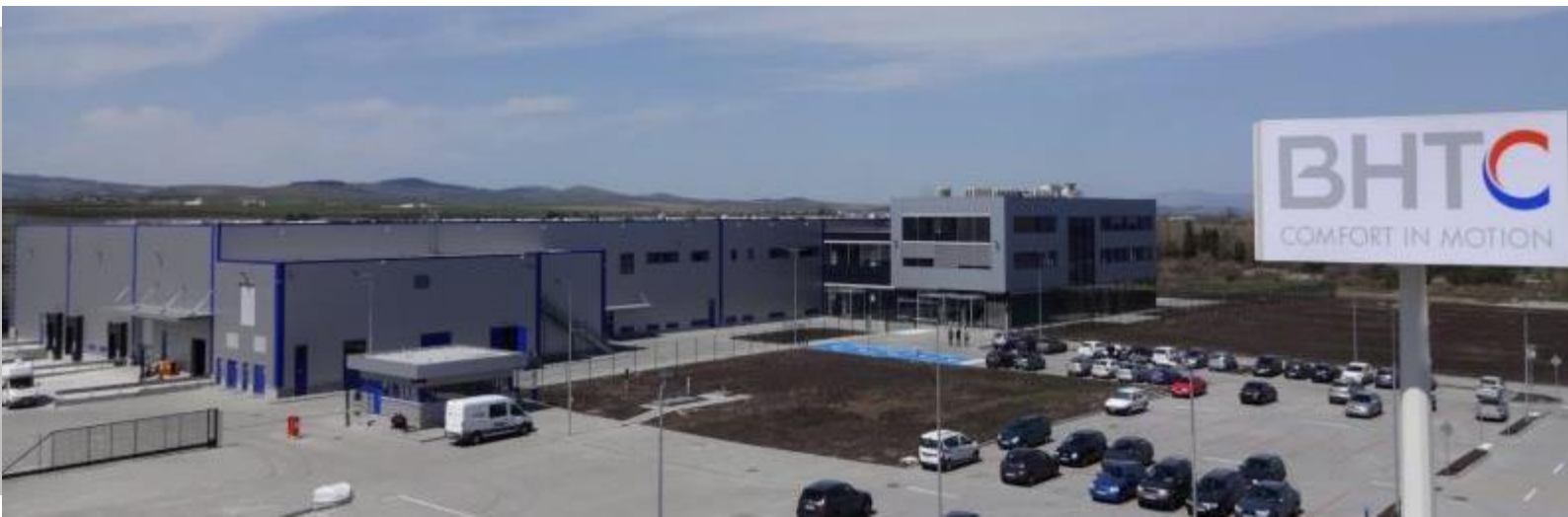
Инвеститор: Бер - Хелла Термоконтрол ЕООД РЗП: 14 693 m 2
